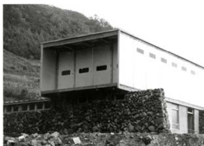
宝台樹ヒュッテ(1963 年 11 月竣工) 1 階は石組み、2 階はアルミニウム製
