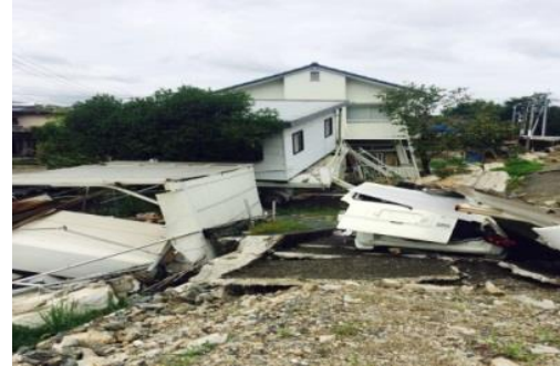
↑崖に崩れ落ちた家。この辺りは断層があり大半の建物が立入禁止となっている。
